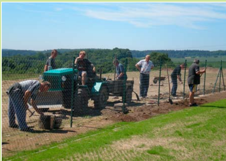
Brigádníci při dokončovacích pracích, červen 2009
