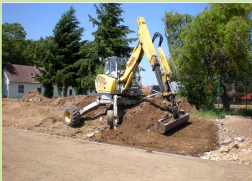
Terénní úpravy okolí, květen 2009
