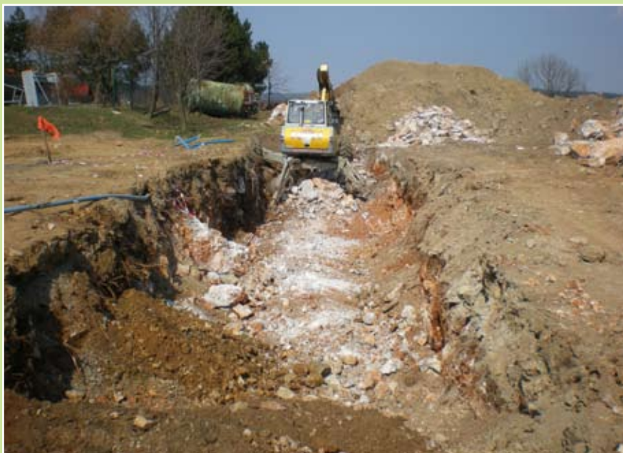
Zemní práce na akumulční nádrži, duben 2009
