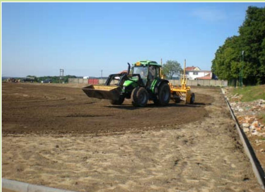
Příprava vegetační vrstvy, květen 2009
