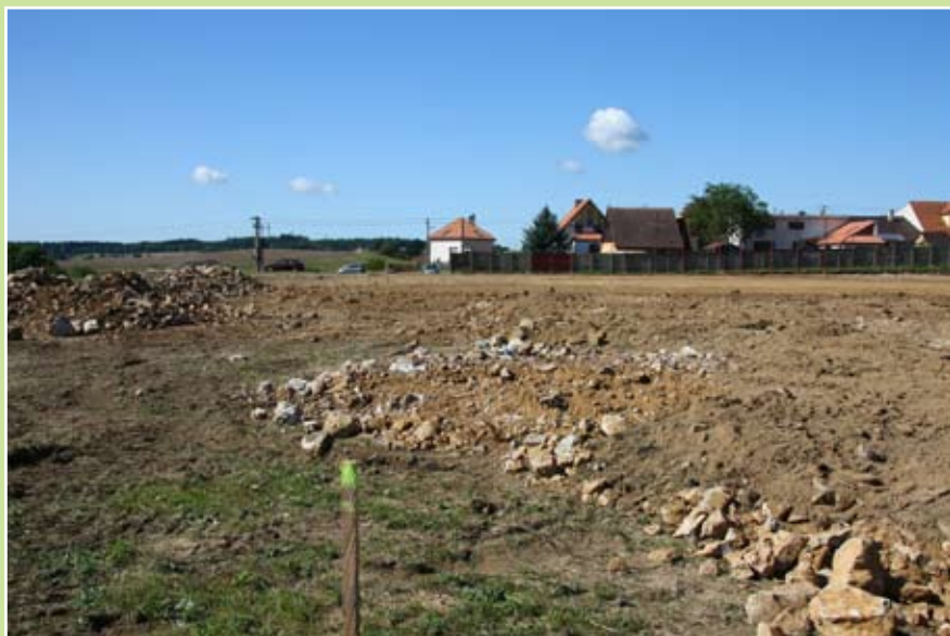
Hřiště při rekonstrukci v roce 2009
